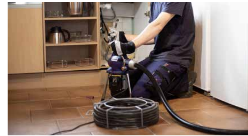
De Wöhler RM 200 ontstoppingsmachine met beschermingslang maakt een schone reiniging van de keukenafvoer mogelijk.
