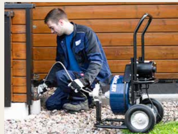
Afvoerputten kunnen ook buiten worden gereinigd met de Wöhler RM 400 ontstopingsmachine.
